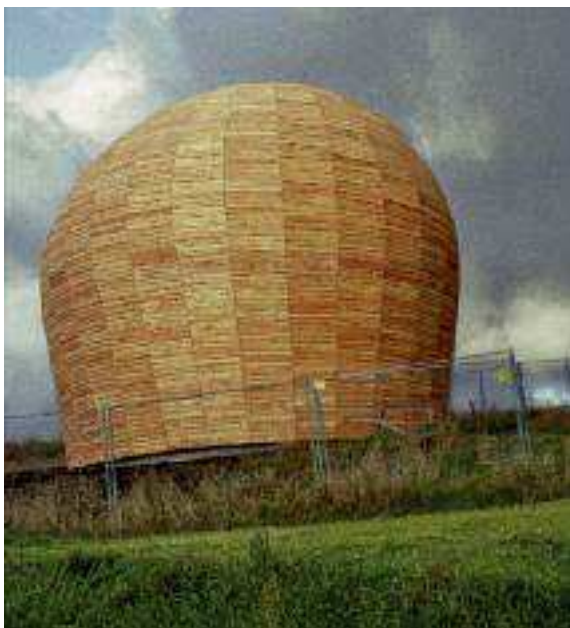
Gebäudehülle aus unbehandelter »lebendiger« Lärche © Barbara Schmid
