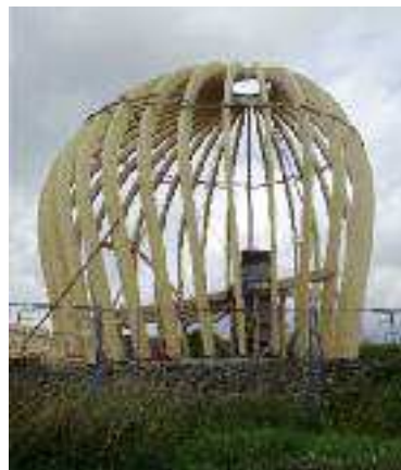
Grundkonstruktion aus Leimbindern © Barbara Schmid
