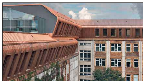
Die besondere Form der ein- und zweigeschossigen Aufstockung der Metropolitan School Berlin schafft viel neuen Platz und wertet den Plattenbau architektonisch auf. Fotos: Sauerbruch-Hutton-Architekten/Jan Bitter
