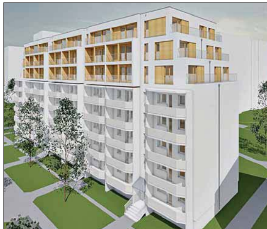
Drei Geschosse aus Holz erweitern den fünfgeschossigen Bestand nach oben und geben dem ursprünglichen Plattenbau ein neues Gesicht. Mit der Typenplanung für solche Wohnhäuser geht die Wohnungsbau-Gesellschaft als Initiatorin voran. Rendering: Howoge Berlin
