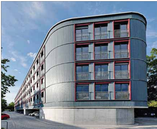
Die Parkplatzüberbauung mit einem langgestreckten viergeschossigen Gebäuderiegel aus Massivholz namens „Dantebad I“ ist eines der Vorzeigeprojekte in München. Dank Aufständerung des Holzbaus auf einem Betonisch konnten fast alle Parkplätze erhalten bleiben. Foto: Roland Weegen
