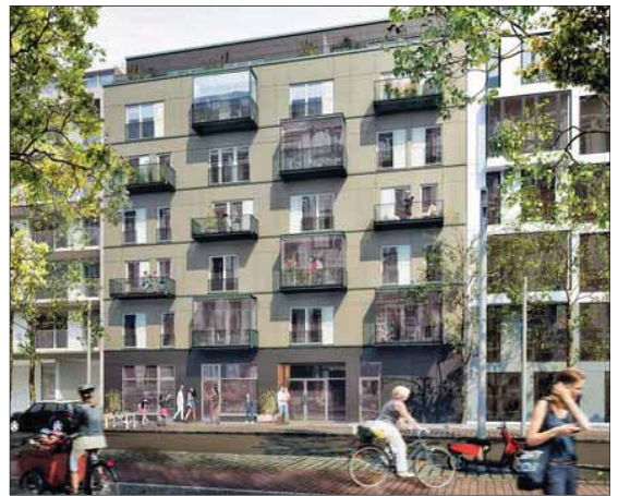
Beim ökologischen Siebengeschoss-Holzhaus „Linse“ in Berlin sind die Fassaden zur Straße mit Faserzementplatten und zum Hof hin mit unbehandeltem Lärchenholz bekleidet. Zu beiden Seiten werden Balkone ausgebildet, die zur Straße teilweise mit Glas eingehaust sind. Rendering: Render-Manufaktur
