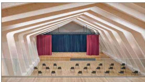
Die Aufstockung der Metropolitan School Berlin erfolgte mit speziell geformten Rahmenkonstruktionen, die mit Wandelementen aus Brettspertholz ausgesteift und mit Hohlkastendecken überspannt wurden.
