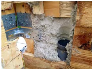
*Auch am Beispiel der freigelegten Rohre ist deutlich zu erkennen: die Zellulosefasern haben 21 Jahre lang passgenau und fugenfrei alle Hohlräume ausgefüllt. (Bild: Isocell / Pronaturhaus)*
