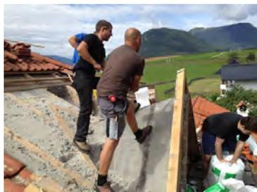
*Bei jedem freigelegten Bereich dasselbe Bild: die 17 Jahre alte Zellulosedämmung wirkt wie frisch eingeblasen. (Bild: Isocell)*
