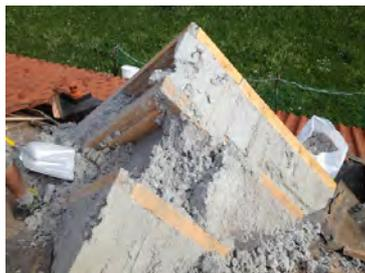
*Beim Umbau einer Dachgaube eines vor 17 Jahren mit Zellulose gedämmten Hauses stießen die Arbeiter ebenfalls auf unversehrte, lückenlose Dämmung. (Bild: Isocell)*
