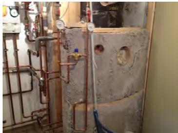
*Auch hinter der Verkleidung eines Wärmetauschers im Keller des Hauses zeigte sich die Langlebigkeit und Formbeständigkeit von ISOCELL-Zellulose. (Bild: Isocell)*
