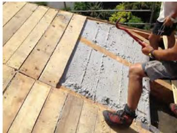
*Auch im Unterdach: unversehrte, formstabile Zellulose. (Bild: Isocell)*
