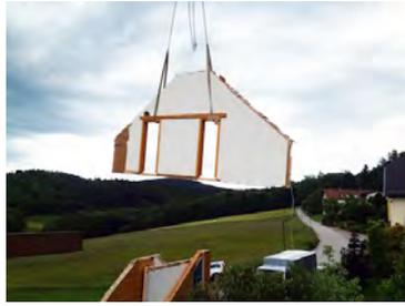
*Einzelteile des Hauses wurden nach dem Ausbau per Kran entfernt ... (Bild: Isocell / Pronaturhaus)*
