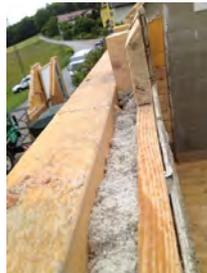
*Beim Abtragen zeigte sich deutlich: Die in den Außen- und Zwischenwänden zur Dämmung eingebrachte Zellulose wies selbst nach mehr als zwei Jahrzehnten im Einsatz keinerlei Spuren von Setzung oder Verformung auf. (Bild: Isocell / Pronaturhaus)*
