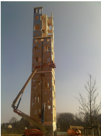
Aussichtsturm während der Montage
