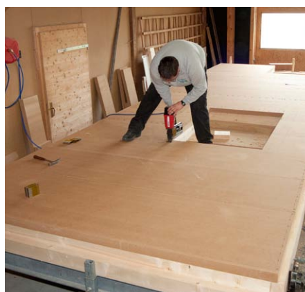
Knauf WF THD N+F: Optimal für die Vorfertigung von Wandelementen.
