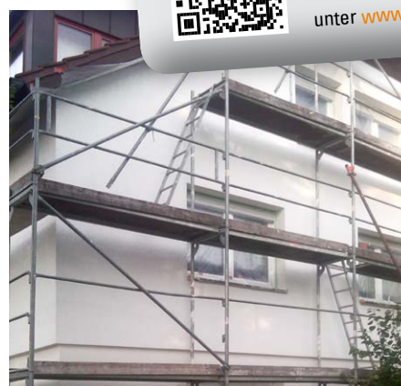
Mit der Knauf WF THD N+F kann eine schnelle Fertigstellung des Objektes erfolgen. Vorteil: Grundputzauftrag „frisch in frisch“ möglich.
