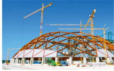
Rubner Holzbau realisiert aktuell den Bau von zwei Brettschichtholzkuppeln zur Überdachung der Kohlelager der Enel-Zentrale "Federico II" in Brindisi, einem weltweit führenden Unternehmen im Energiesektor. Das Projekt verdeutlicht das große Umweltbewusstsein von Enel, das sich nicht zuletzt im Einsatz des natürlichen Baustoffes Holz ausdrückt.
