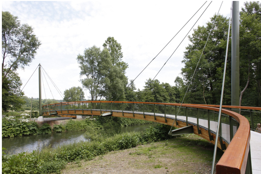
Gesamtansicht der Pylonbrücke über die Agger
