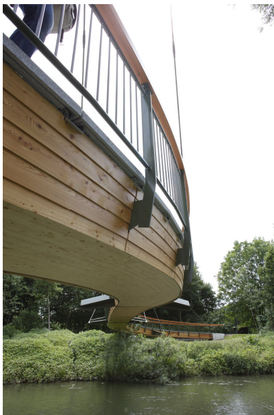
Deutlich sichtbare S-Form des Brückenlängsträgers
