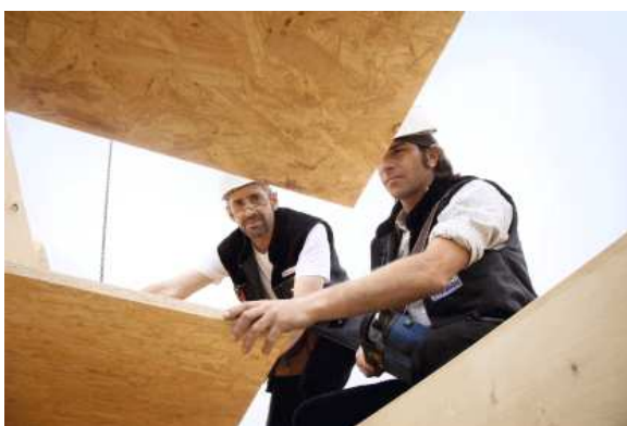
Verlegung großformatiger OSB-Platten auf der Baustelle
